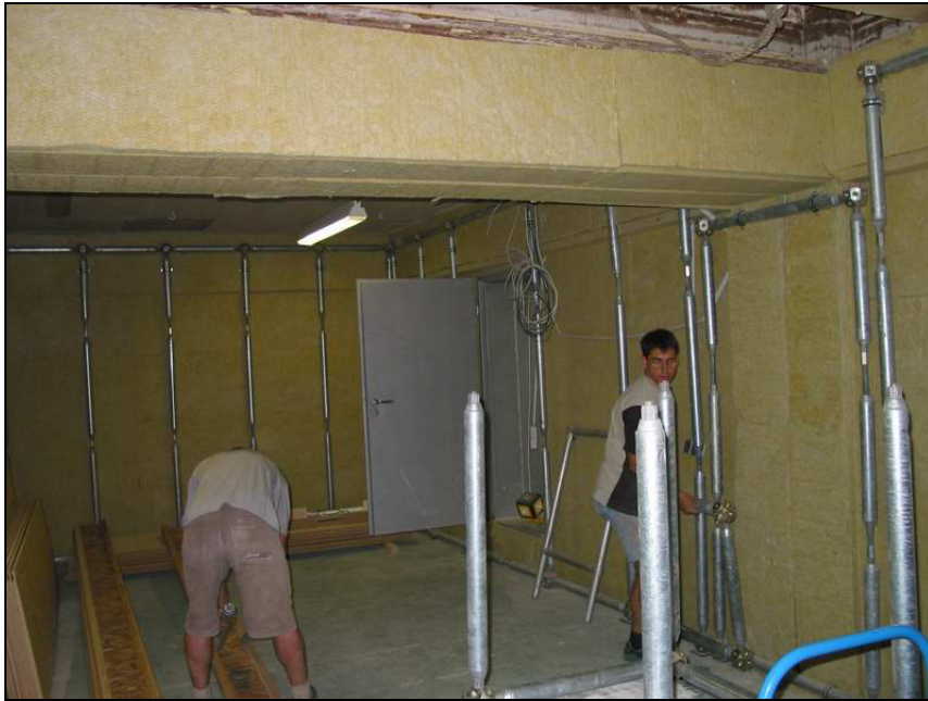
Abbildung 80 Unterkonstruktion für Vorsatzschale im Empfangsraum, abgedämmter Baukörper
