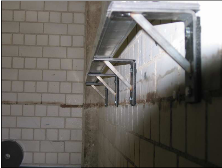
Abbildung 76 Konsolen für die Vorsatzschale im Senderaum
