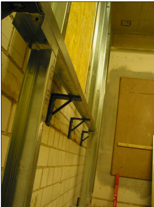
Abbildung 77 Unterkonstruktion für Vorsatzschale im Senderaum
