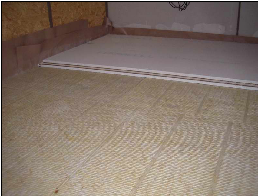
Abbildung 16 Verlegung des Fermacell 2E22-Estrich-Elementes auf der Trittschalldämmung, Stufenfalz mit doppelter PU-Kleber-Spur
