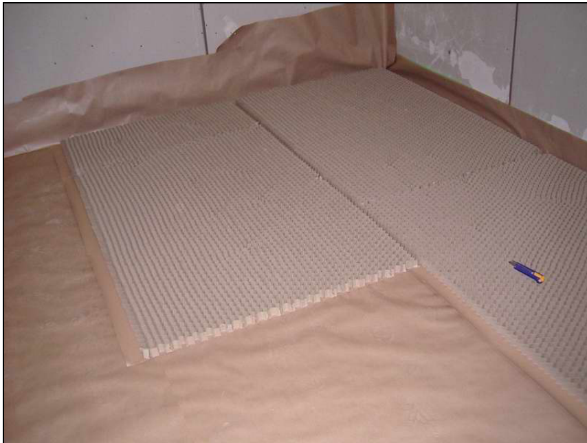
Abbildung 18 Pappwaben auf Rieselschutzfolie
