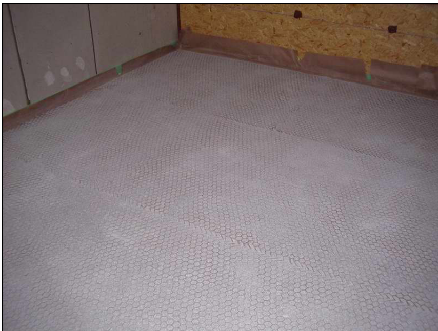
Abbildung 19 fertige Rohdeckenbeschwerung
