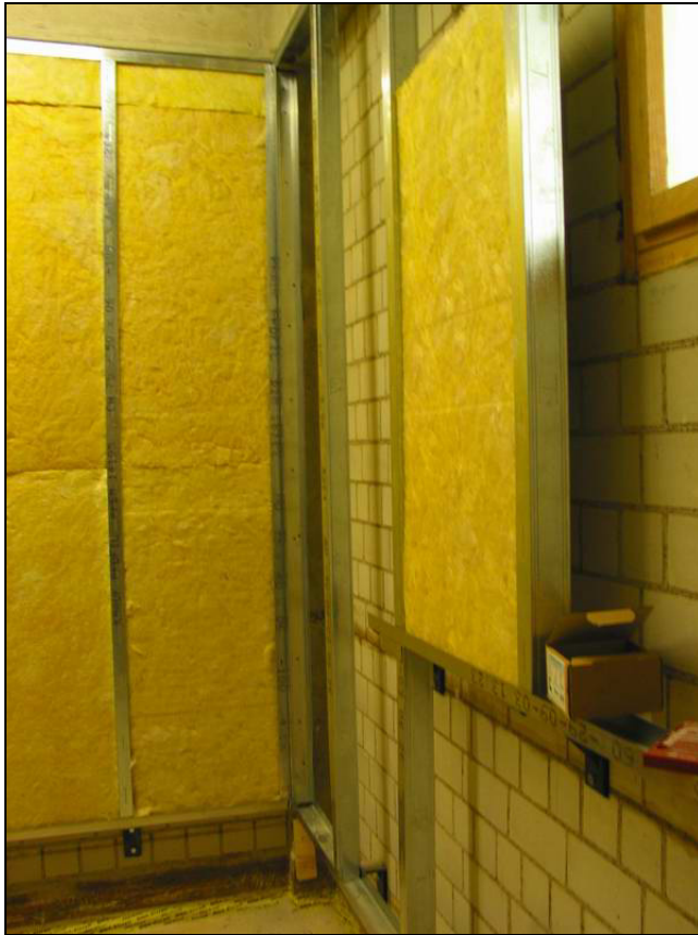
Abbildung 78 Unterkonstruktion für Vorsatzschale im Senderraum
