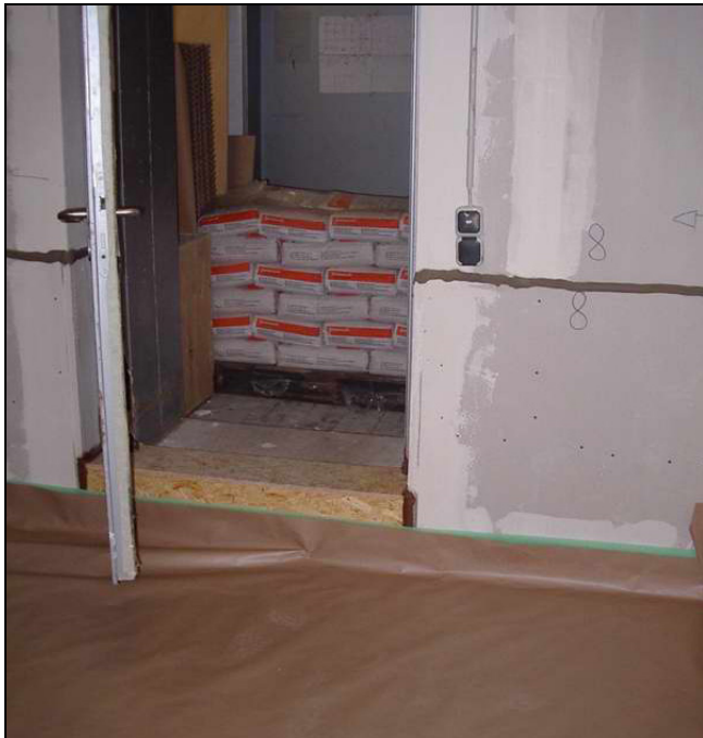
Abbildung 20 Bereitstellung der Schüttung in Säcken
